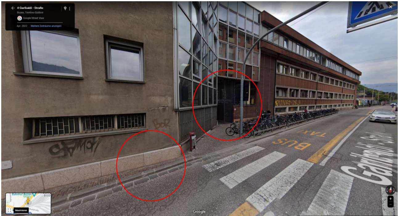
Schmalere Gehsteig und verschlossener Durchgang zum Bahnsteig.
